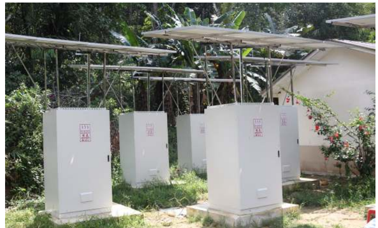
Sebahagian daripada sistem fotovolta suria (PV) yang telah selesai dipasang
