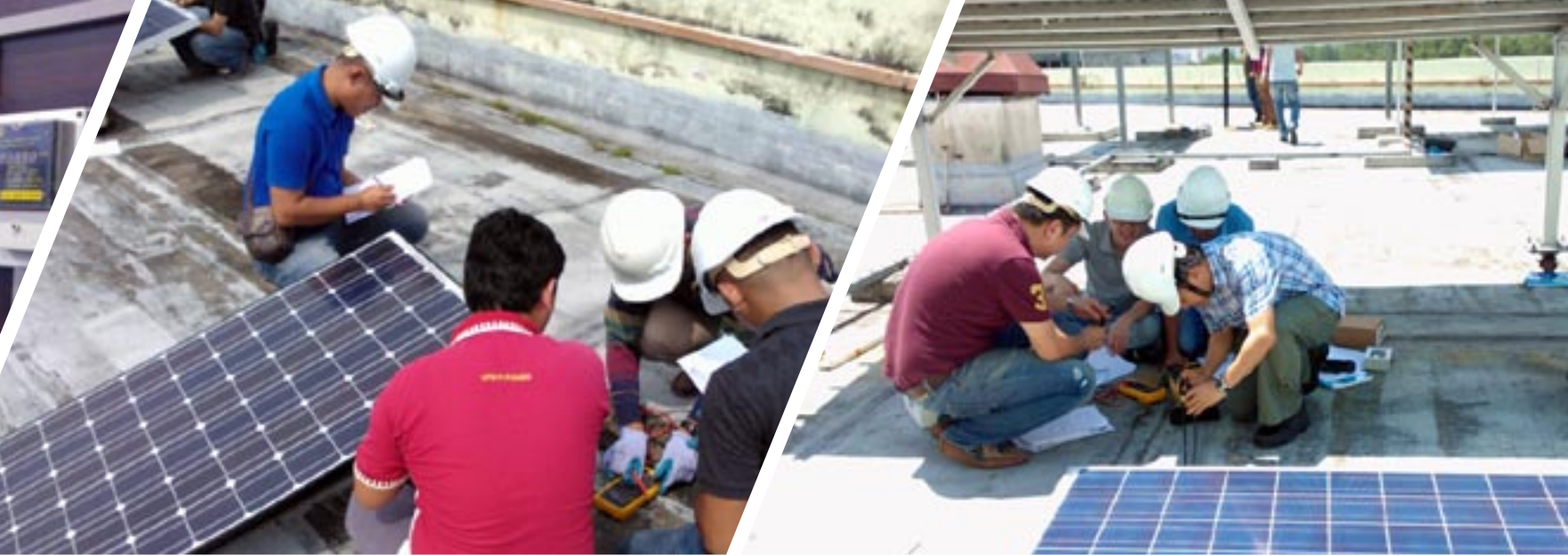
Kursus Pemasangan dan Penyenggaraan Sistem Fotovolta Suria Tersambung Grid (GCPV) Grid-Connected Solar Photovoltaic (GCPV) Systems Installer and Maintenance Course
