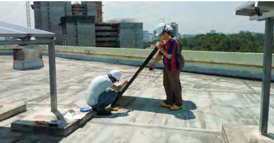
Sesi latihan amali sistem solar PV untuk pendawai dan penjaga jentera elektrik. / Practical session on Solar PV systems for wireman and chageman.
