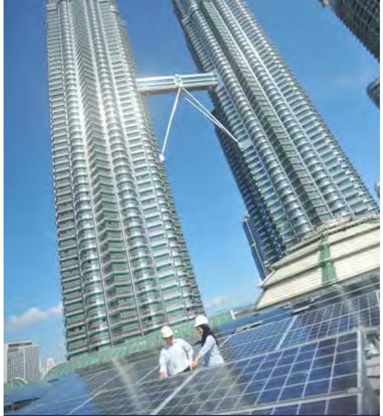
Salah satu pencalonan oleh SEDA bagi Anugerah Industri KeTTHA 2013 (sistem solar PV 684.7kW, Petronas Berhad). / One of nominations by SEDA for KeTTHA Industry Award 2013 (684.7kW Solar PV system, Petronas Berhad).
